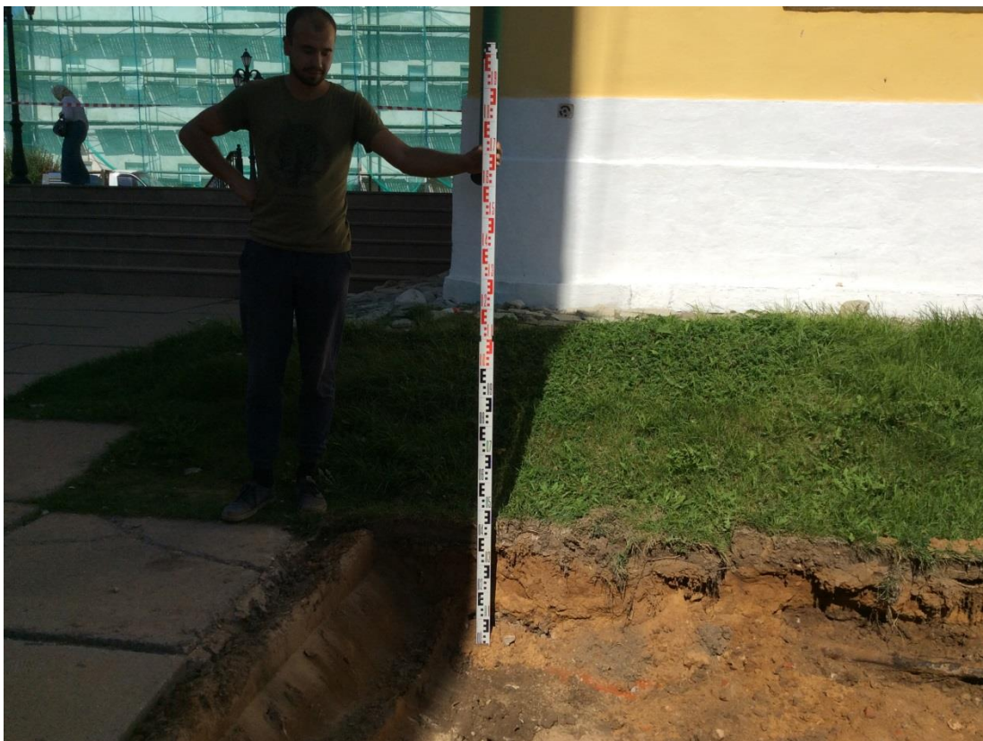
Рис. 29. Пафнутьев-Боровский монастырь. Зачистка грунта.
